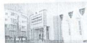
В Мордовии после капитального ремонта открылся кукольный театр
