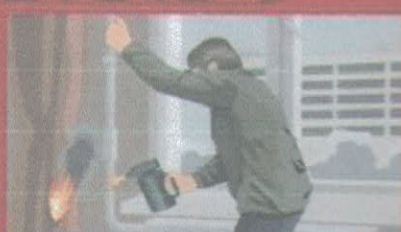
Отогревание замерзших труб паяльными лампами и факелами
